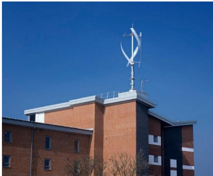
Figura 6. Ejemplo de turbina de eje axial en cubierta de edificio
